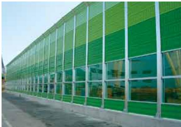
흡음률 및 음향특과손실이 우수하고 경제성 대비 감음효과가 매우 뛰어나 가장 많이 사용되는 방음벽 형태이다. 시공이 용이하고 내구성 및 경제성이 탁월 하며, 외부에 다양한 색상창출이 가능하다. 방음판의 흡음률은 NRC 0.7 이상, 투과손실은 500Hz의 음에 대하여 25dB이상, 1000Hz의 음에 대하여 30dB이상을 표준으로 한다.
