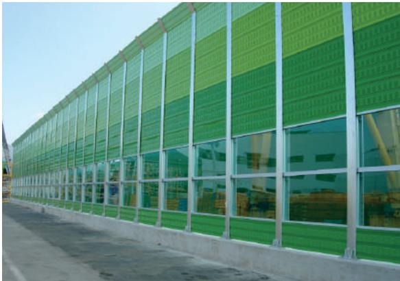
흡음률 및 음향투과손실이 우수하고 경제성 대비 감응효과가 매우 뛰어나 가장 많이 사용되는 방음벽 형태이다. 시공이 용이하고 내구성 및 경제성이 탁월 하며, 외부에 다양한 색상창출이 가능하다. 방음판의 흡음률은 NRC 0.7 이상, 투과손실은 500Hz의 음에 대하여 25dB이상, 1000Hz의 음에 대하여 30dB이상을 표준으로 한다.
